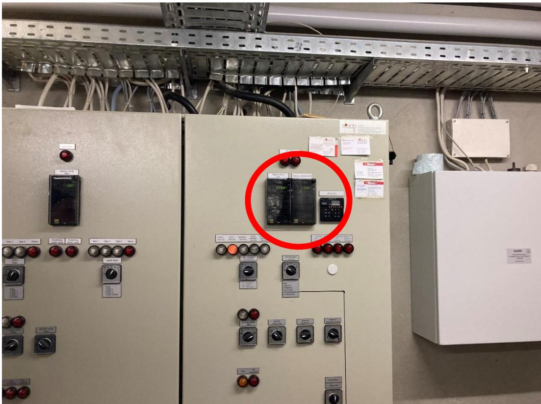
Abb. 15: Steuerung/Regelungstechnik (Ersatzteil Beschaffung schwierig)
