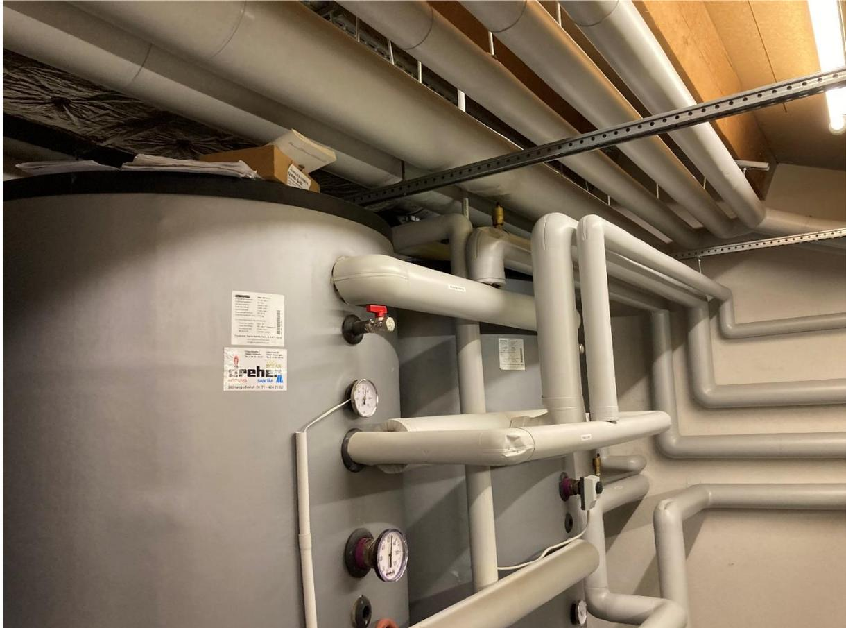
Abb. 19: Pufferspeicher für Solarthermie
