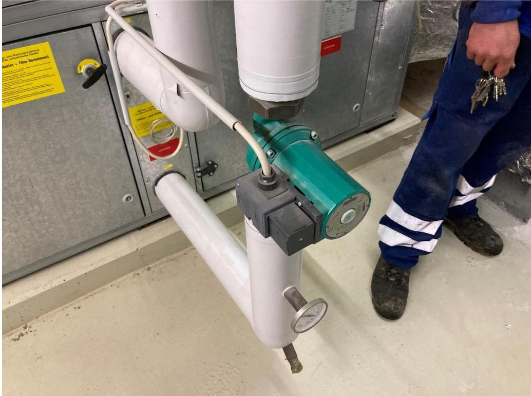
Abb. 14: unregelte Pumpe Lüftung
