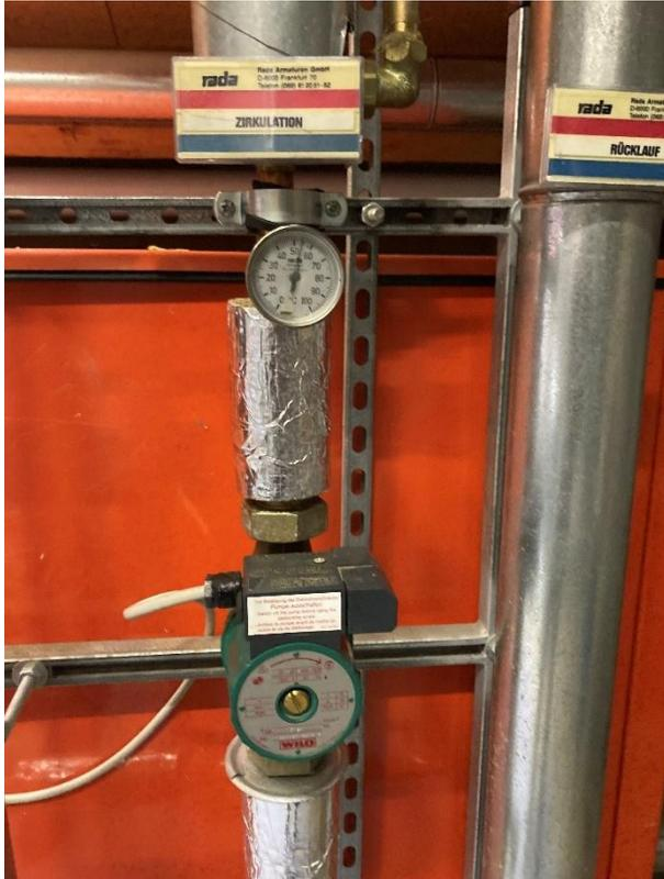
Abb. 12: unregelte Zirkulationspumpe WW
