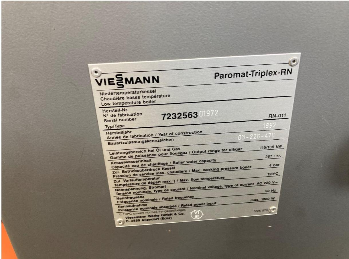
Abb. 17: Gaskessel Typenschild
